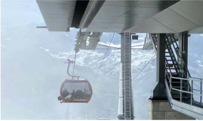
De kabelbaan van Zinal
